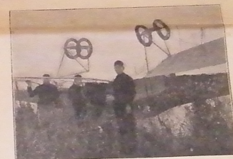
A Mougins (Var) le premier avion belge, construit par le comte de la Roche, a été inauguré le 28 juin 1914.
