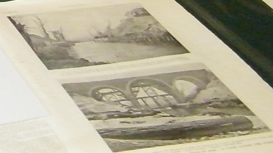
1919 RECONSTRUCTION Le viaduc sur la Scarpe
